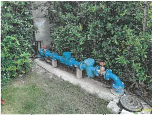
มิเตอร์น้ำสำหรับห้องพัก และพื้นที่ส่วนกลาง
