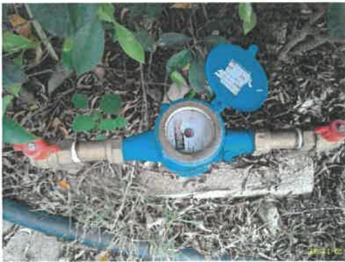
มิเตอร์น้ำสำหรับร้านค้า 1
